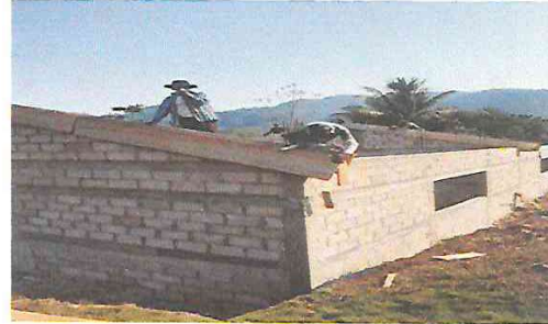
Foto 4: Se observa el avance de la construcción de las paredes de las dos aulas.
