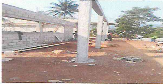
Foto 5: Se observa la fundición de los pilares para el corredor de las dos aulas.
