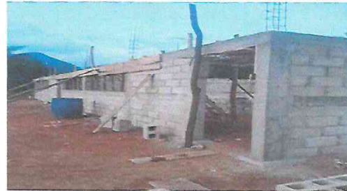
Foto 2: Se observa la fundición de las soleras de las dos aulas.
