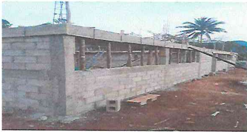
Foto 1: Se observa el avance del trabajo en el mejoramiento de las paredes
